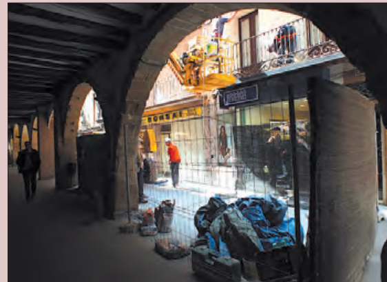
Restauració de façanes
