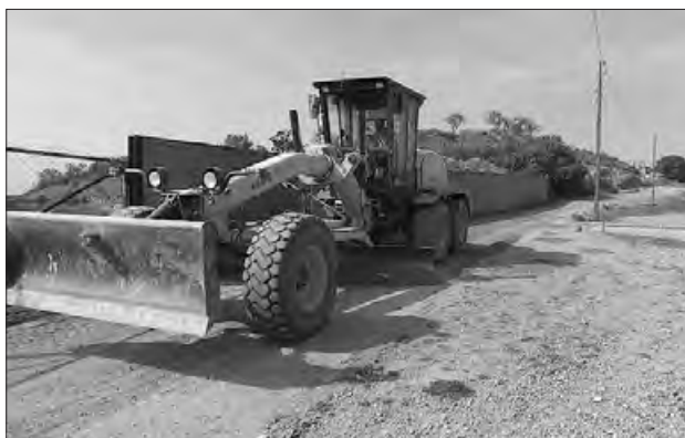
Arranjament de camins rurals
