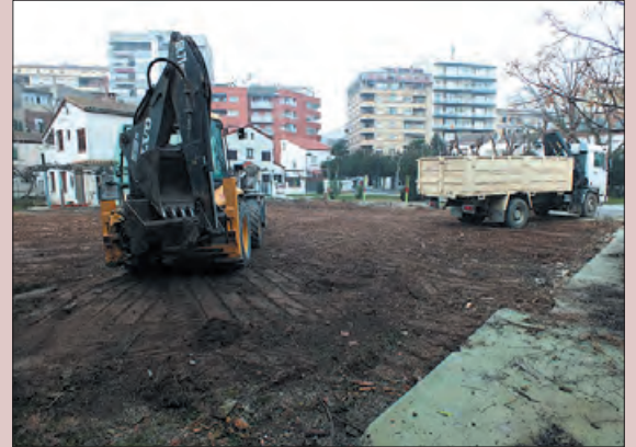
Obres d'adequació del pàrquing
