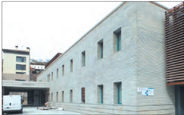
Fi de les obres al CAP
