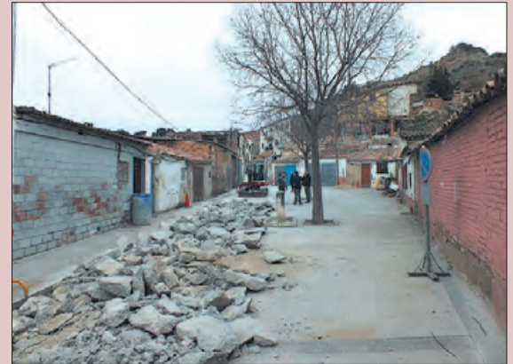
Obres al carrer Cuartel
