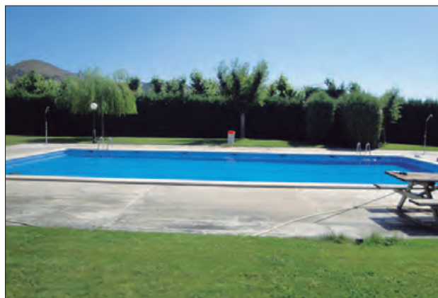
Piscines municipals d'Algerri
