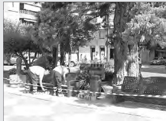
Treballs de manteniment
