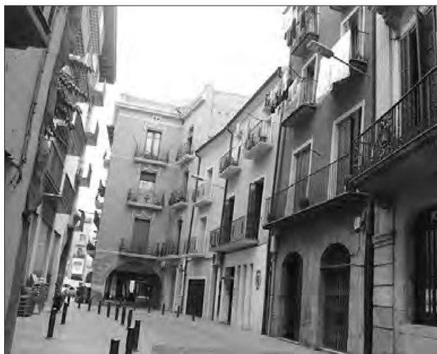
Façanes del carrer Miracle
