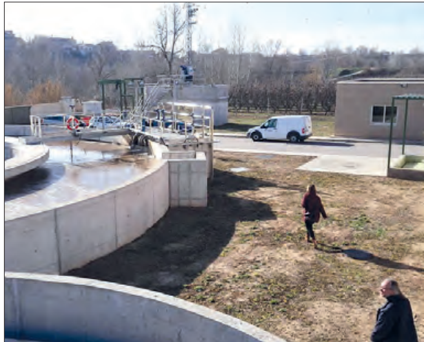
Depuradora Menàrguens - Térmens
