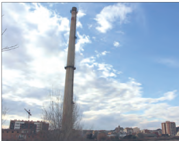
El projecte d'Inpacasa no s'executarà aquest exercici
