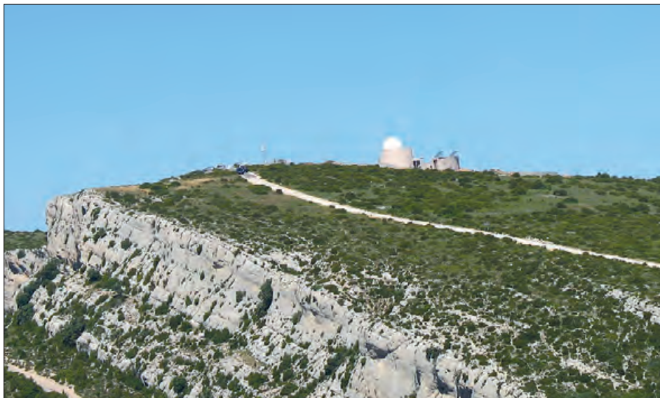
Instal·lacions a Sant Esteve de la Sarga
