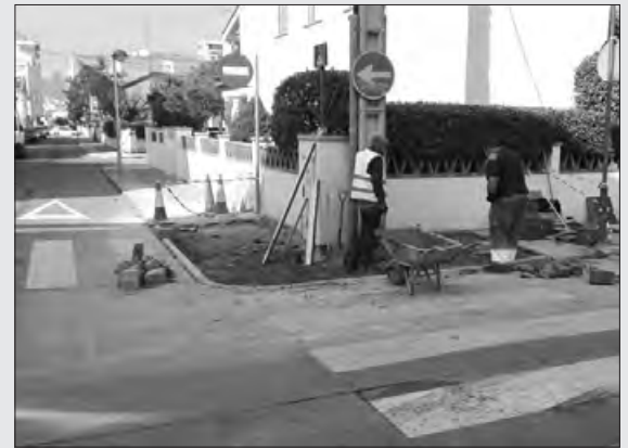
Obres de millora
