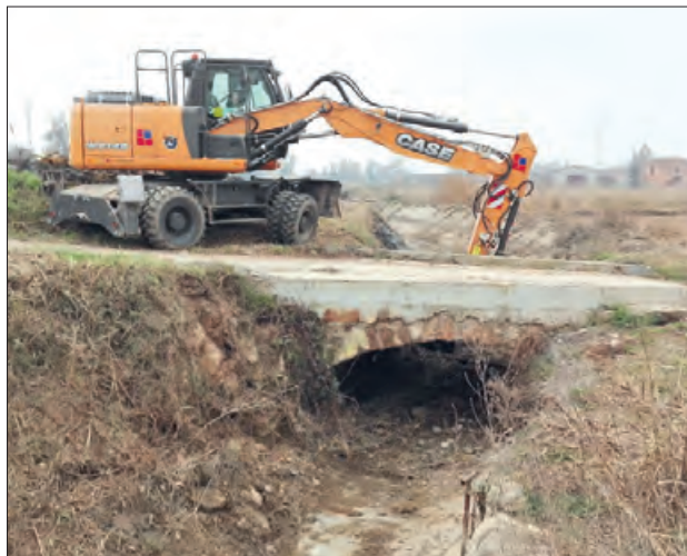
Obres a la sèquia del Molí del Comte
