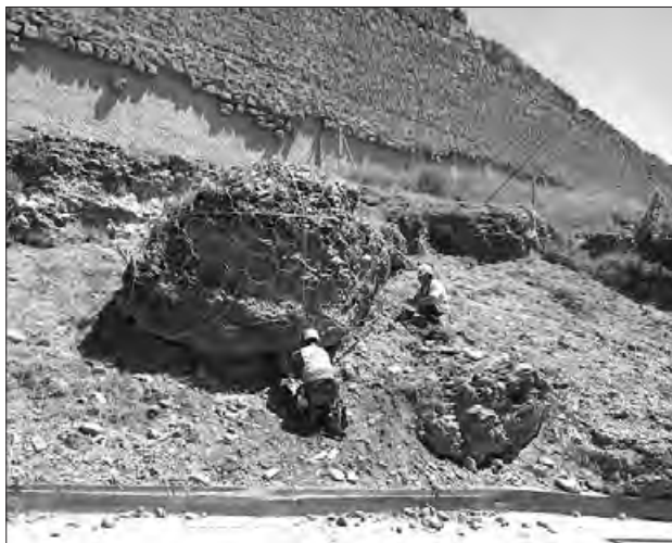
Protecció de talussos
