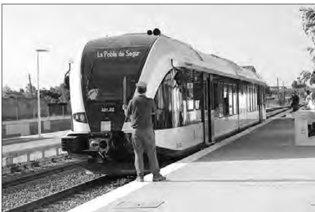
Obres de millor en la línia del tren de la Pobla
