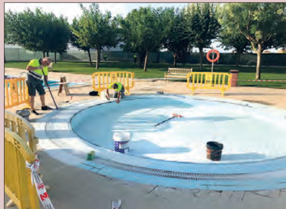
Obres de millora a les piscines
