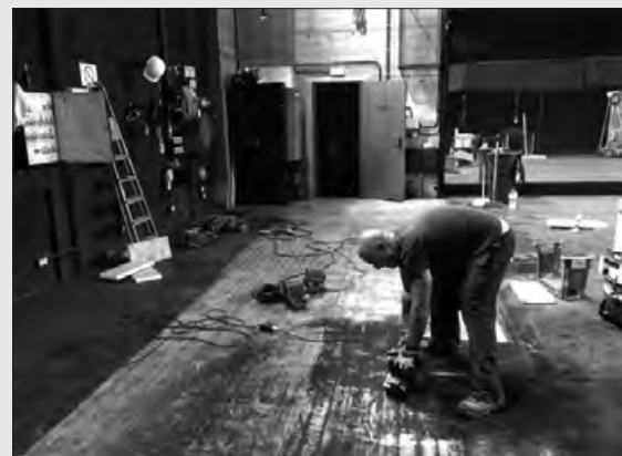
Reparació del Teatre
