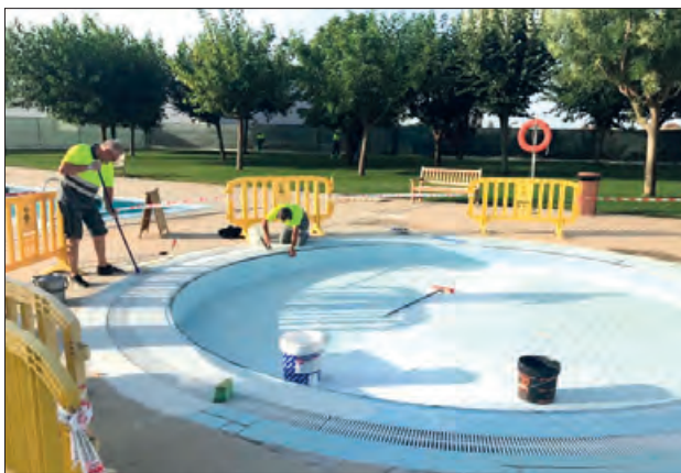
Obres a la piscina
