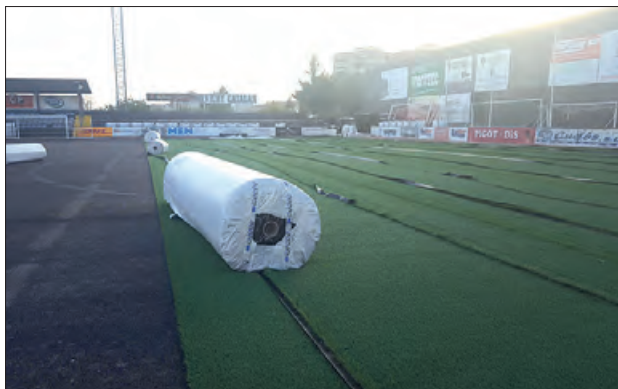
Instal·lació de la nova gespa
