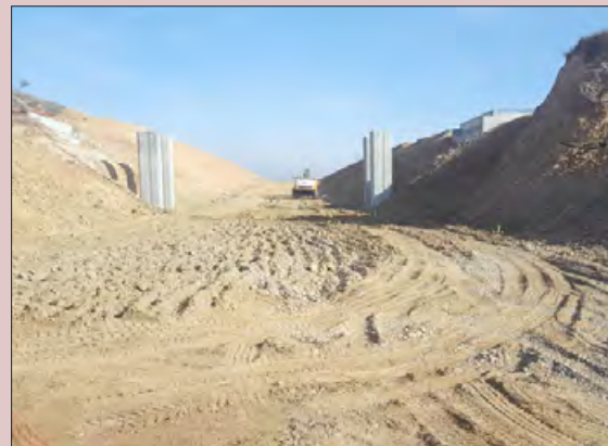
Obres de la variant nord
