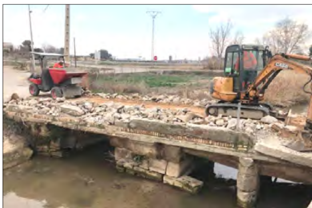
Pont de Montgai
