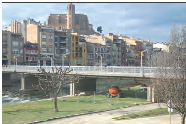
Obres del pont nou
