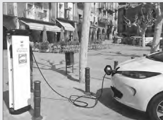
Punt de càrrega de vehicles elèctrics
