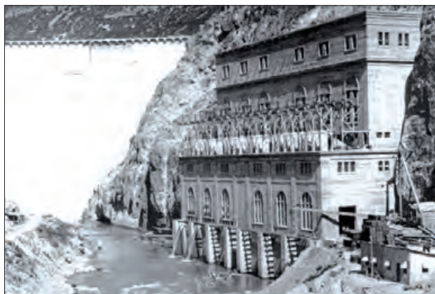
Central de Camarasa
