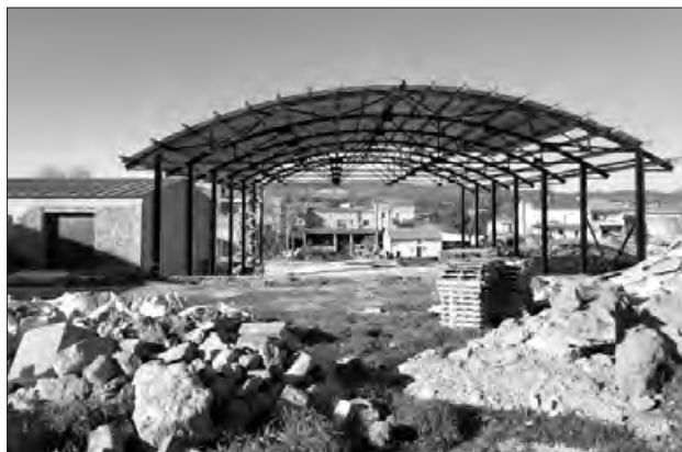
Obres del nou pavelló de Montgai
