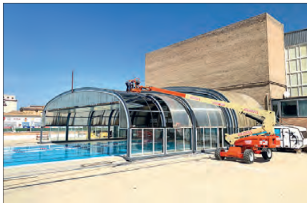
Obres a la piscina coberta
