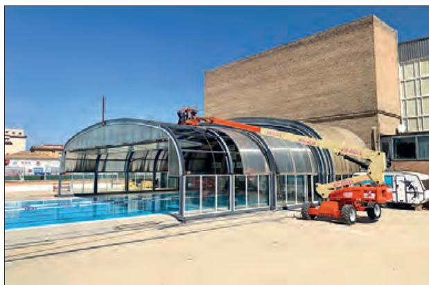
Obres a la piscina coberta
