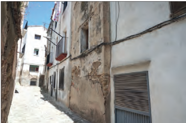
Obres a fer al Carrer Minerva
