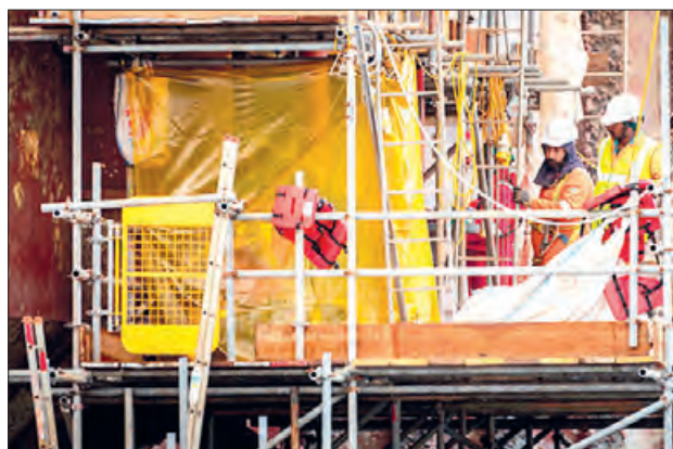
Rehabilitació d'edificis residencials
