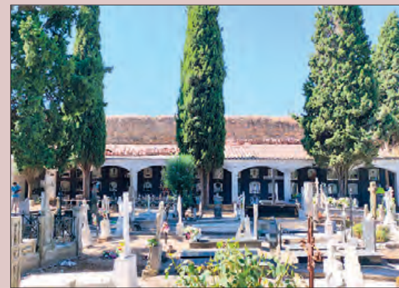
Obres de la teulada
