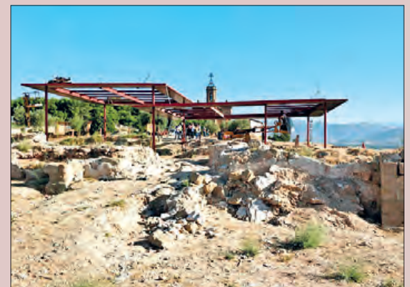
Obres al castell Formós
