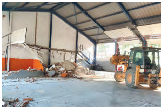
Obres al Parc de Bombers de Balaguer
