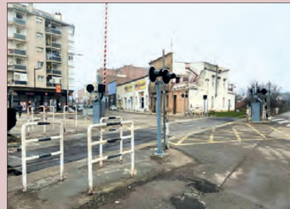
Zona a reformar
