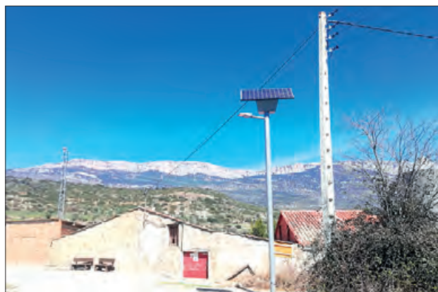
Nou fanal instal·lat a la Règola
