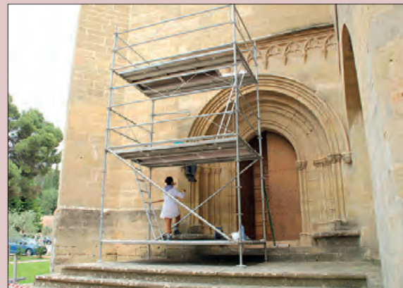
Obres de restauració
