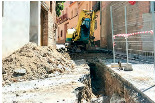
Obres de clavegueram a Térmens
