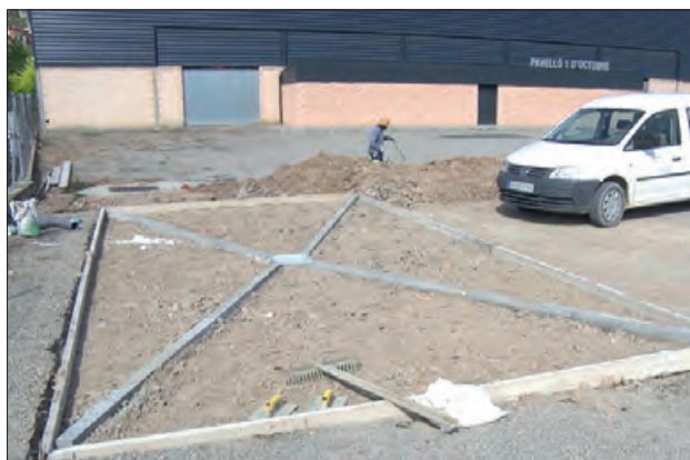
Obres de construcció del nou pàrking
