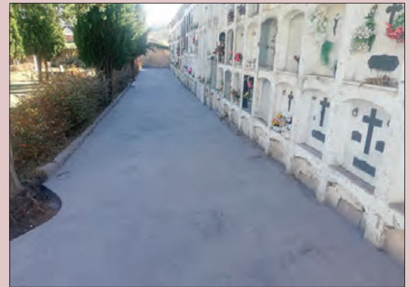
Tasques de pavimentació del cementiri d'Àger
