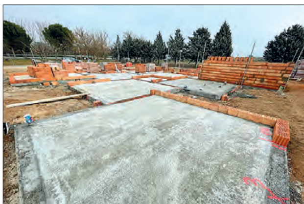
Obres del nou centre de serveis a la Sentiu
