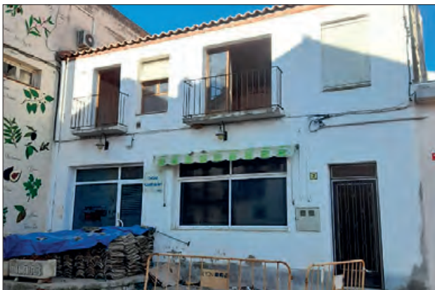
Obres de l'alberg de peregrins d'Algerri
