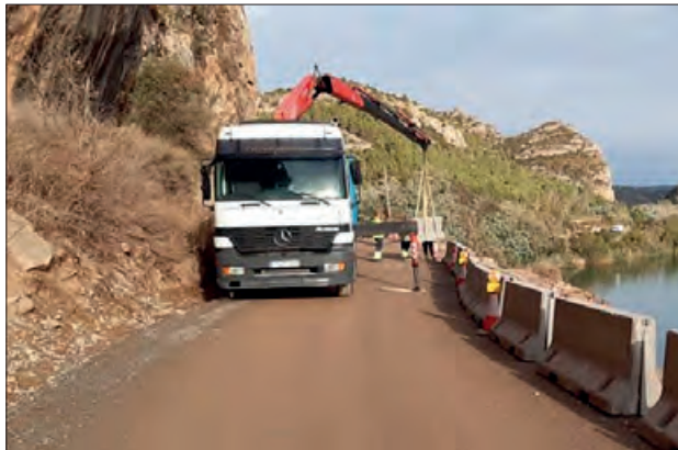
Obres a la carretera entre Sant Llorenç i Camarasa
