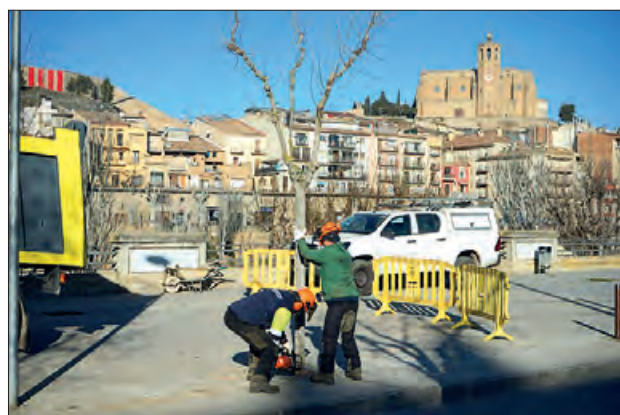
Obres de revegetació
