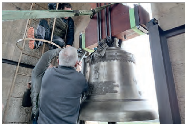
Instal·lació de la nova campana
