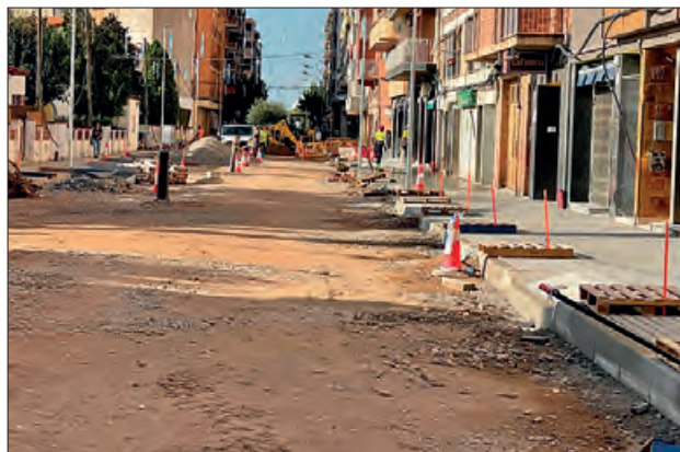
Obres del carrer Barcelona
