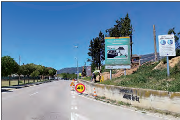
Obres a la carretera d'Àger
