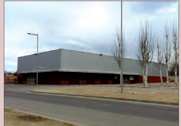
Plaques fotovoltaiques al pavelló Molí de l'Esquerrà
