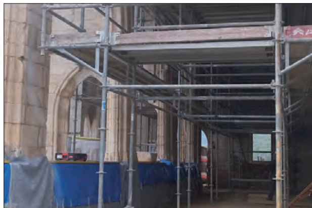
Imatge de les obres
