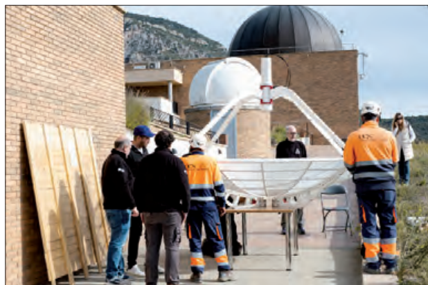
Durant la instal·lació
