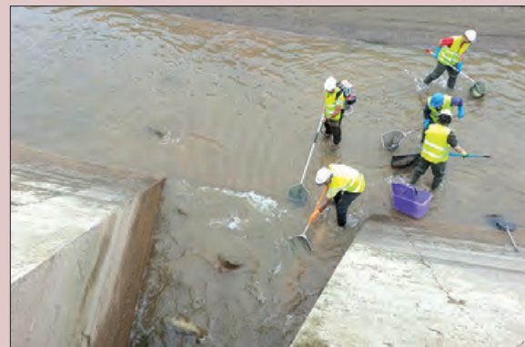
Treballs al canal
